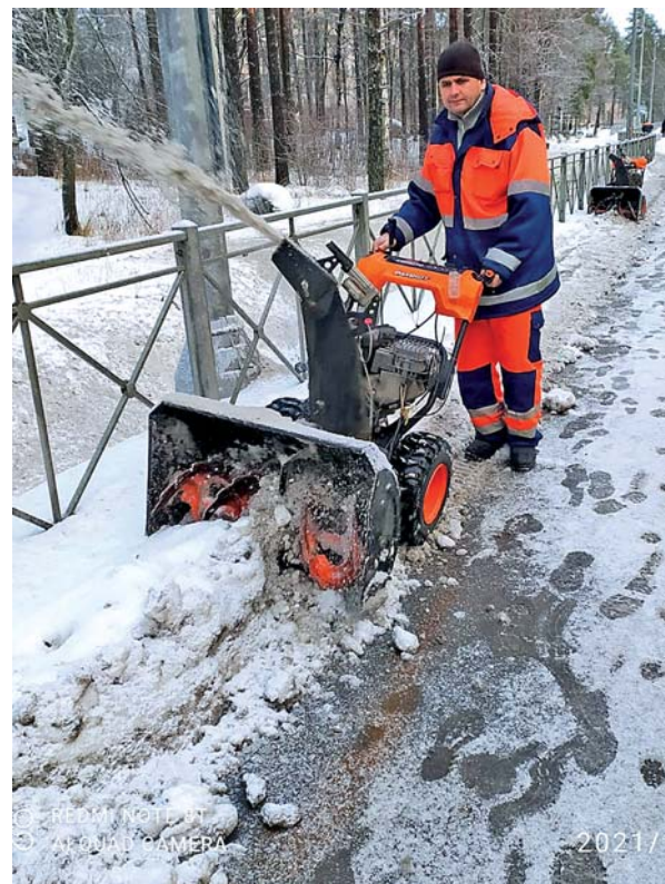
Ведется очистка тротуара на трассе А-121 в черте города Приозерска с использованием шнекоротора.
