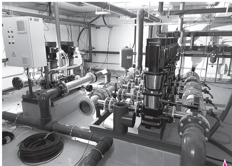
Насосные станции второго подъема и промывных вод. Установку ультрафиолетового обеззараживания (УФО) показывает руководитель проекта Дмитрий Безручко.
