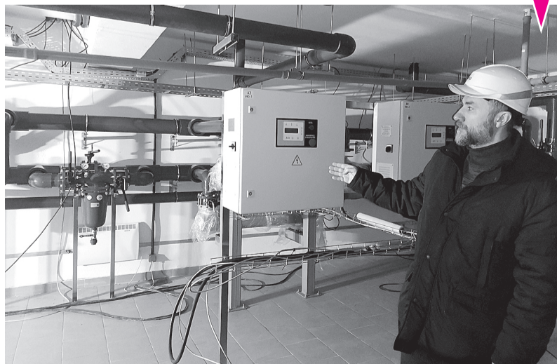
Насосные станции второго подъема и промывных вод. Установку ультрафиолетового обеззараживания (УФО) показывает руководитель проекта Дмитрий Безручко.
