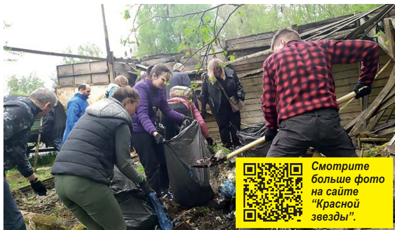
Разборка дряхлых строений в Сосново.
