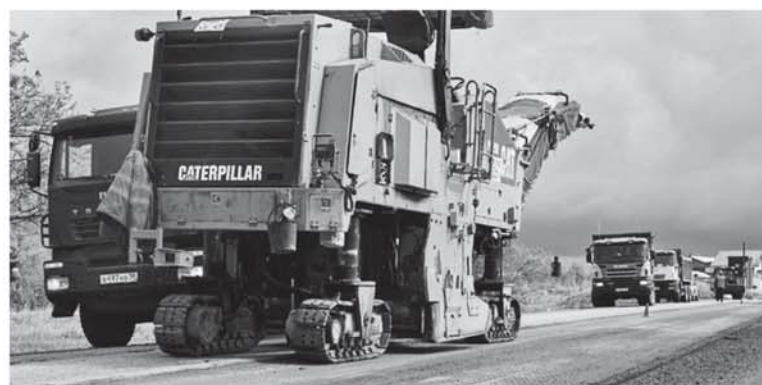
Дорожные работы на региональной трассе Лодейное Поле — Тихвин — Будогощ в Тихвинском районе
