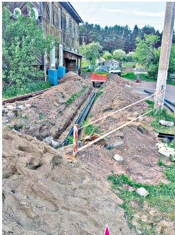
Прокладка теплотрассы в посёлке Моторное.
