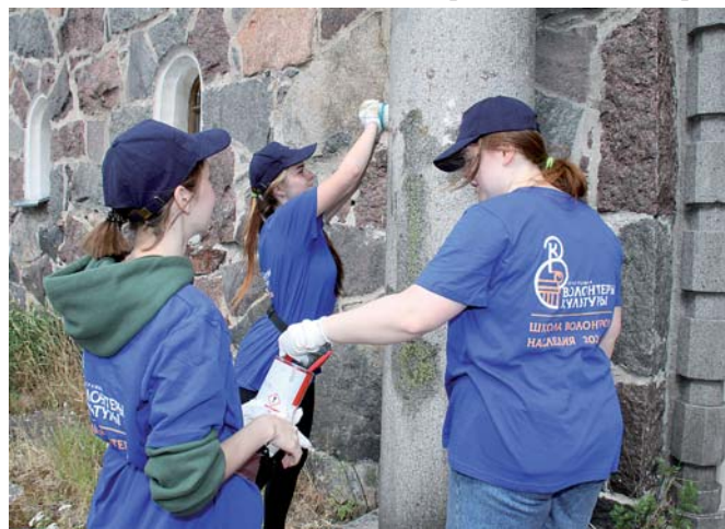
Очистка стен кирхи от граффити.
