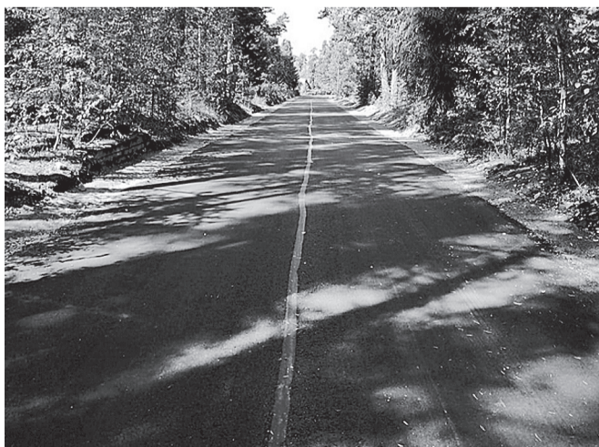
Новая дорога в посёлке Понтонное.
