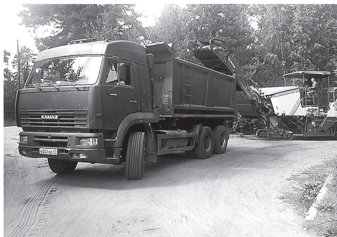
В ремонтных работах было задействовано достаточно специализированной техники.
