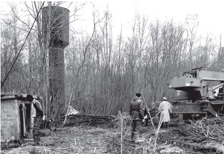
Весной в ржавой водонапорной башне насос заменили, но никакой автоматики, защищающей от перепадов напряжения в электросети, тогда установить не получилось, и он вновь сгорел.
