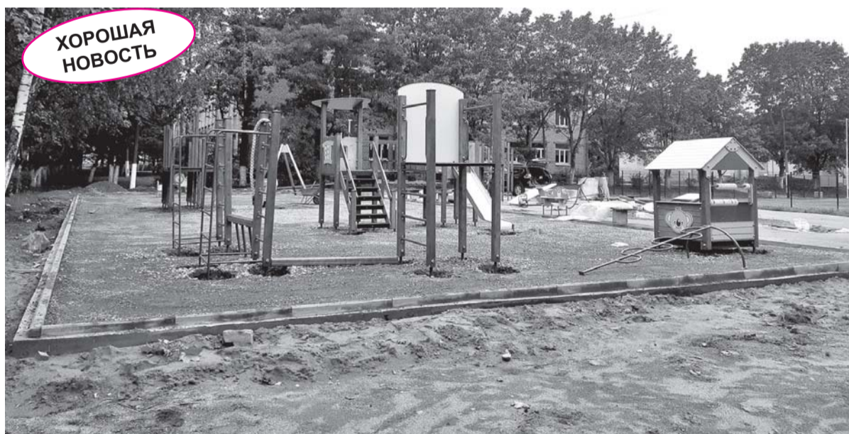
Оборудование нового детского спортивного комплекса СОШ № 5 на этапе установки.
