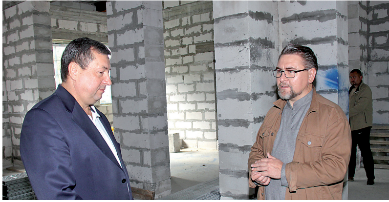
Александр Соклаков и Димитрий Звездилин осматривают ход строительных работ в Духовно-просветительском центре.
