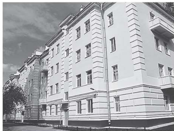
...и после выполнения работ
