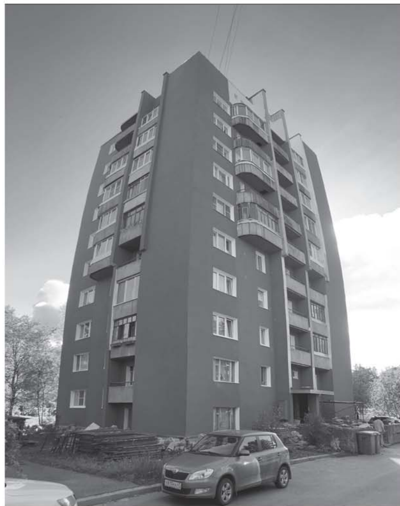
Сосновый Бор. Завершение капремонта на ул. Героев, 11
