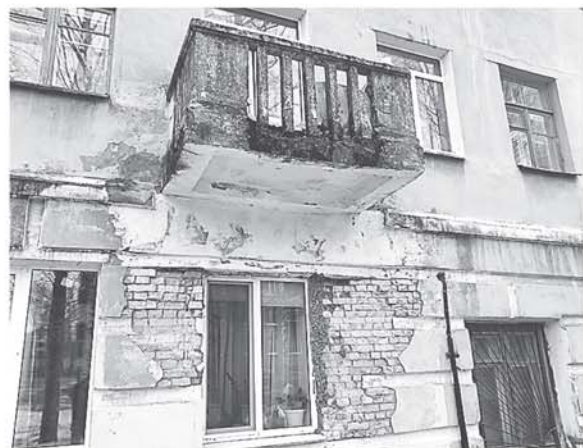
Сертолово (микрорайон Черная Речка). До ремонта...
