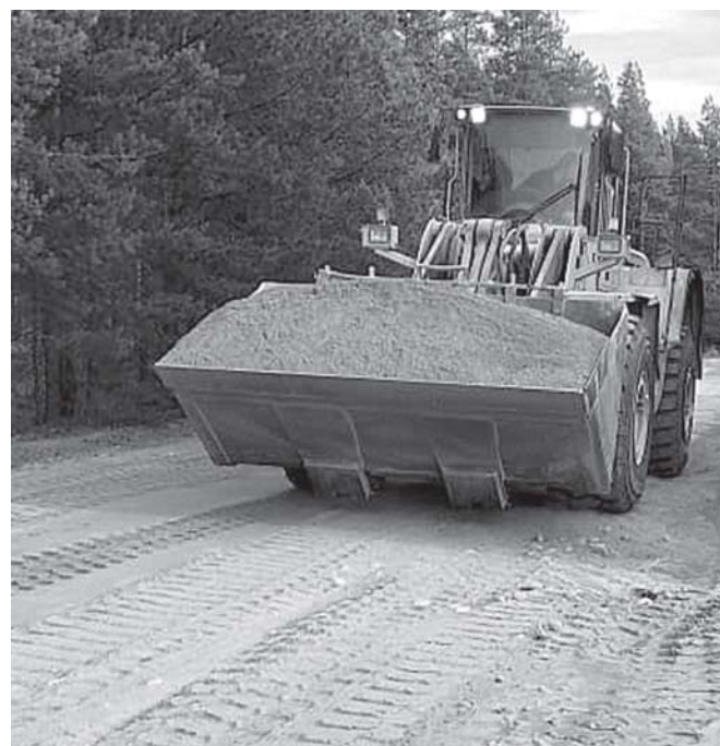
Дорожные работы в пос. Веснино.
