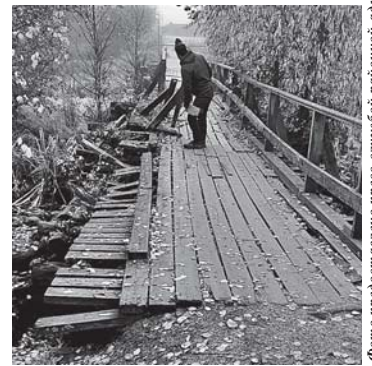
Идёт ремонт «чёртика».
