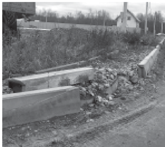
Несостоявшиеся тротуары с бордюрным ограждением.
