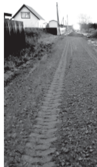
Отсыпка дороги щебеночно-гравийной смесью на улице Народной.
