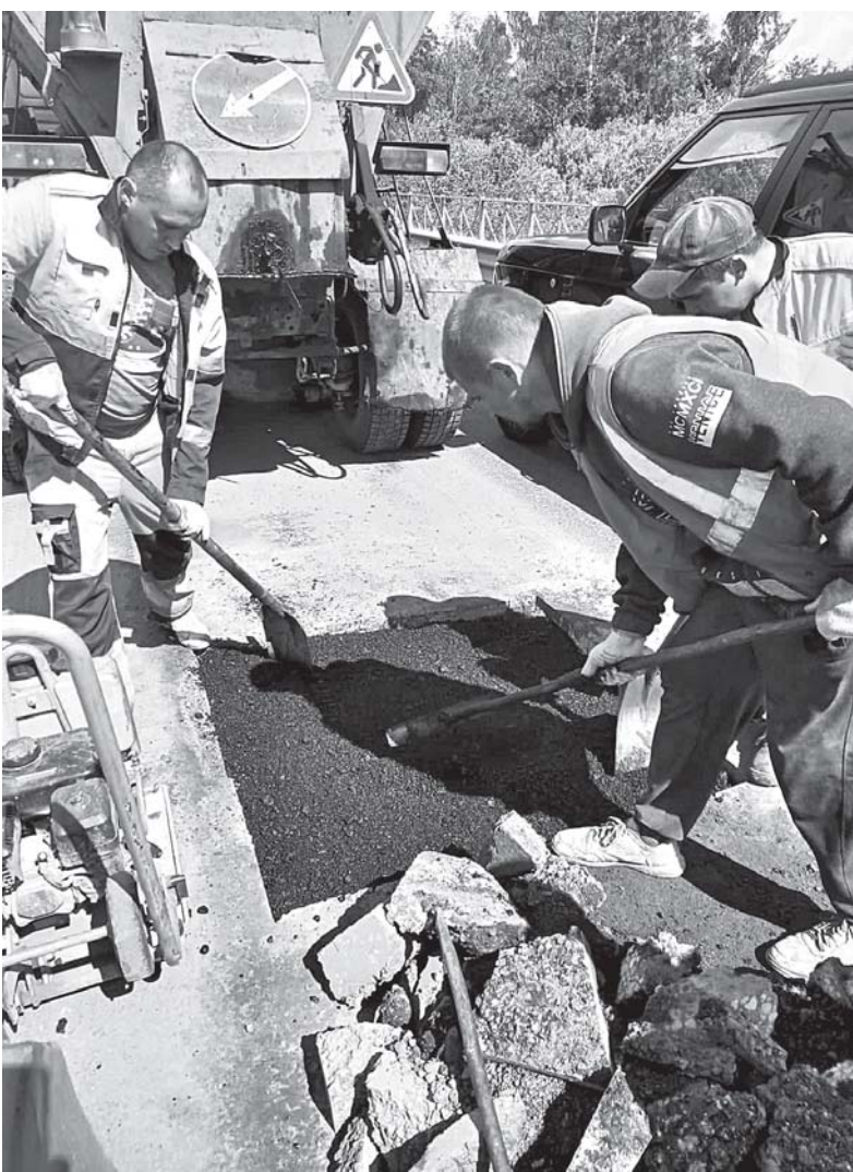
Над приведением дорожного полотна в порядок трудится бригада.
